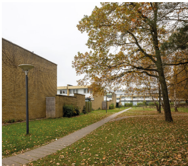
Eksisterende rækkehuse i Birkeparken med høje mure som afgrænsning af haverne. Murene er for høje i dag.
