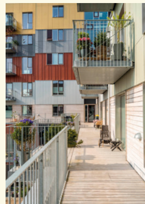
3. Nederste havegang skal ligge ovenpå boliger i stueetagen og må ikke hænge udenpå som en altan
