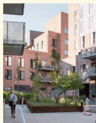
Skift i bygningshøjder
