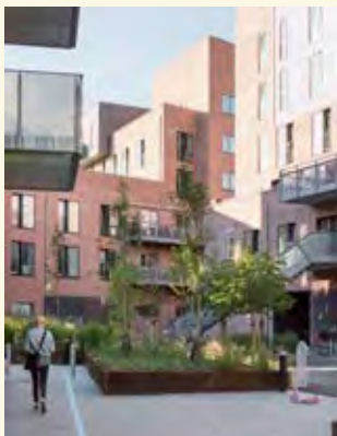
Skift i bygningshøjder
