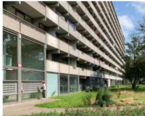
Transformation af stueetage til dobbelthøje indgange og to etagers bokaler i efterkrigsbyggeriet "Bijlmermeer" i Amsterdam. Foto: Vandkunsten
