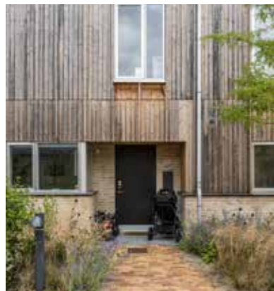
Indgangsniche i "Tingbjerg-husene", Tingbjerg. Foto: Rasmus Hjortshøj
